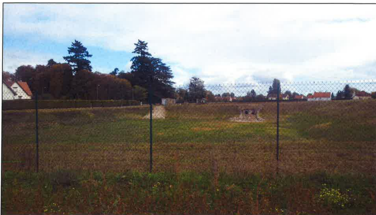
Vue du bassin d'infiltration existant
